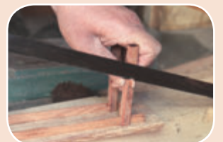
(14) 锯掉榫头多余的部分。
