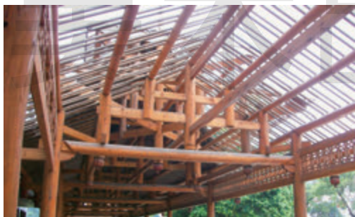
木结构建筑房架
